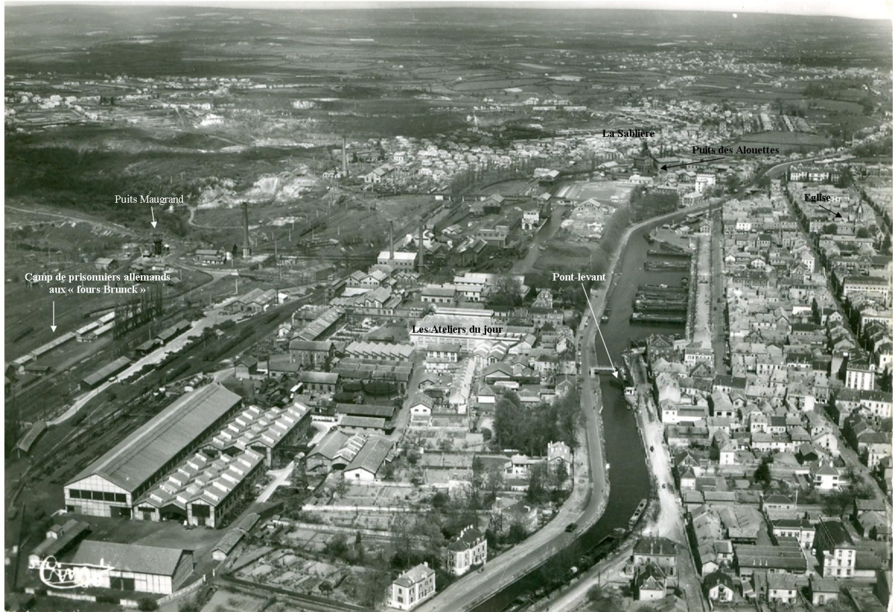
Vue d'avion de Montceau prise vers 1950 où l'on voit encore, à gauche, le camp de prisonniers allemands où se situaient les fours Brunck. ( collection J.C. Michalak)
